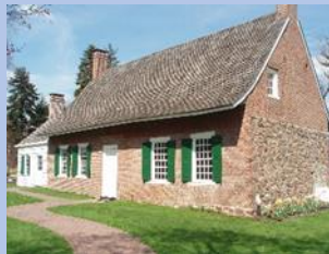
2. Casa de ladrillo
